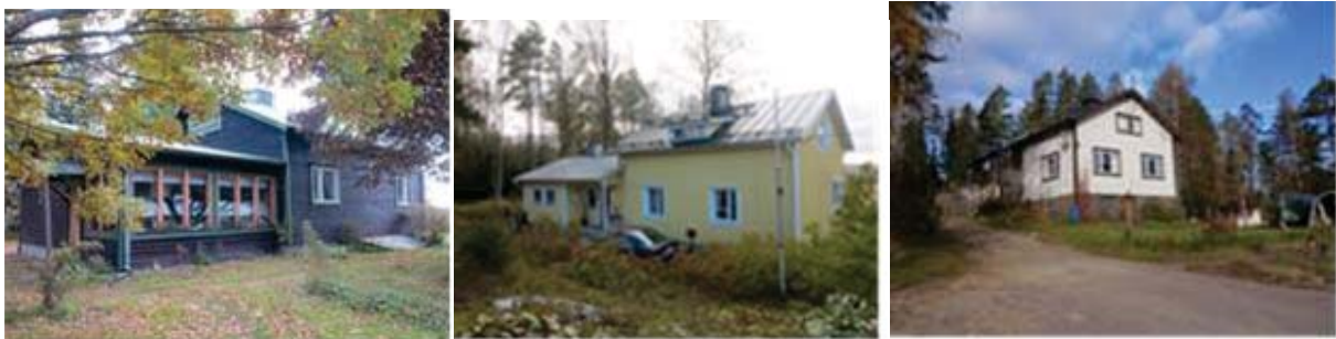
Bild 16. Bostadsbyggnader i Langansböle, tidigt 1950- och 1960-tal. Foto Kristina Karlsson 2015.
